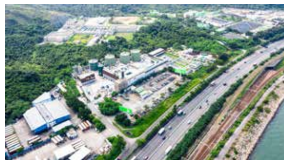
安樂工程與大學及科研機構合作，參與設計、建造及營運的全港首個有機資源回收中心 (O•PARK1)，採用厭氧分解技術來「轉廢為能」，將廚餘轉化成生物氣發電。
