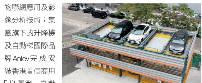
▲ 集團旗下的升降機及自動梯國際品牌Anlev完成安裝香港首個商用「拼圖型」自動泊車系統。
