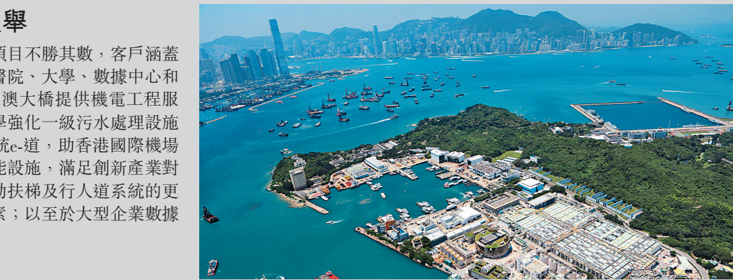
■昂船洲污水處理廠是全球最大之一的化學強化一級污水處理設施，每日可處理達200萬公噸的污水。
