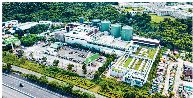
■安樂工程負責設計的有機資源回收中心，可將廚餘廢物轉化為沼氣用於發電和堆肥用途。
