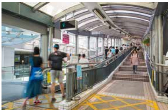
◎安樂工程現正為中環半山自動扶手電梯進行更新工程
