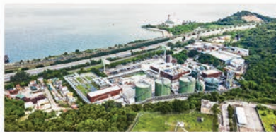
■小塘灣有機資源回收中心O-PARK1每日可處理200噸廚餘廢物，繼而轉化為生物氣用於發電和電燈用途。
