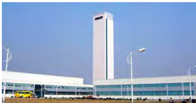
▲ 耗資6,000萬元人民幣的南京廠房擴建工程正邁向完成階段,滿足集團全球業務的未來需求和增長。
