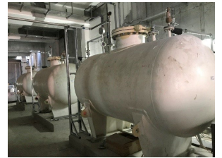
Saturation tank 加压溶气罐
