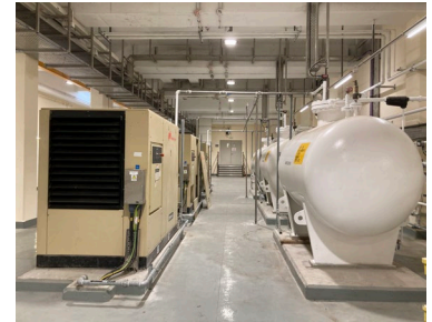
Air compressor system 空气压缩机系统
