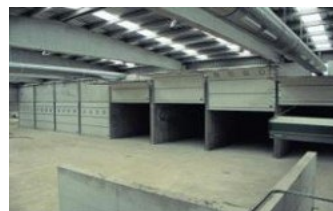
Composting tunnels 堆肥隧道
