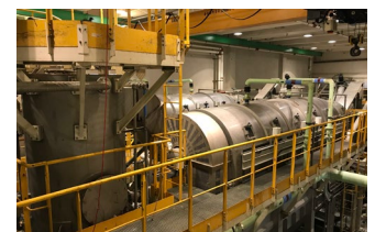
Pre-treatment system 预处理系统
