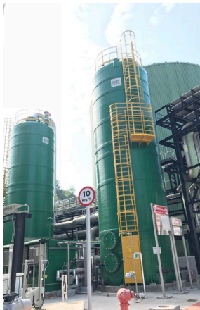
Desulfurisation Device 脱硫装置
