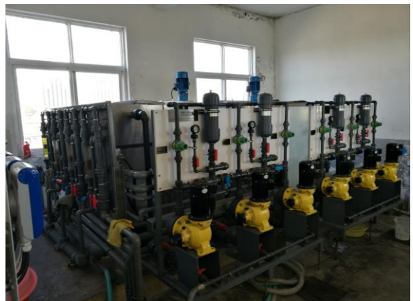
Chemical Dosing System of AMSFS II 磁介质高效沉淀池的加药系统
