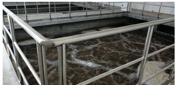
ABAF under backwash 反冲洗中的曝气生物滤池
