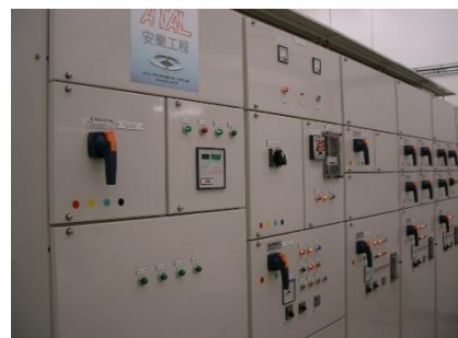
Central Control System 中央控制系统
