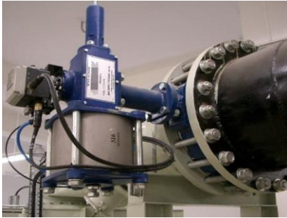
Transfer Pipe 输送管道
