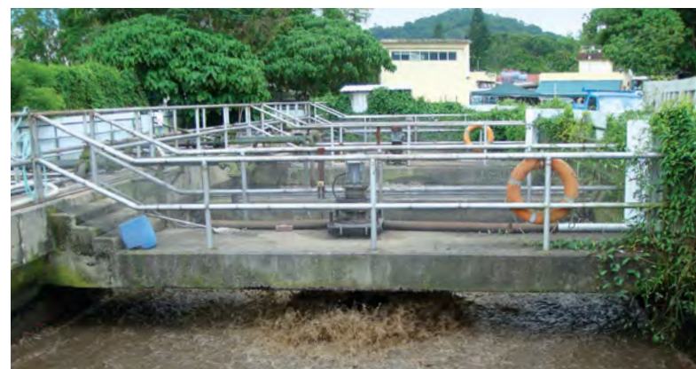
Tai Po Hong Lok Yuen Sewage Treatment Works 大埔康樂園污水處理廠
