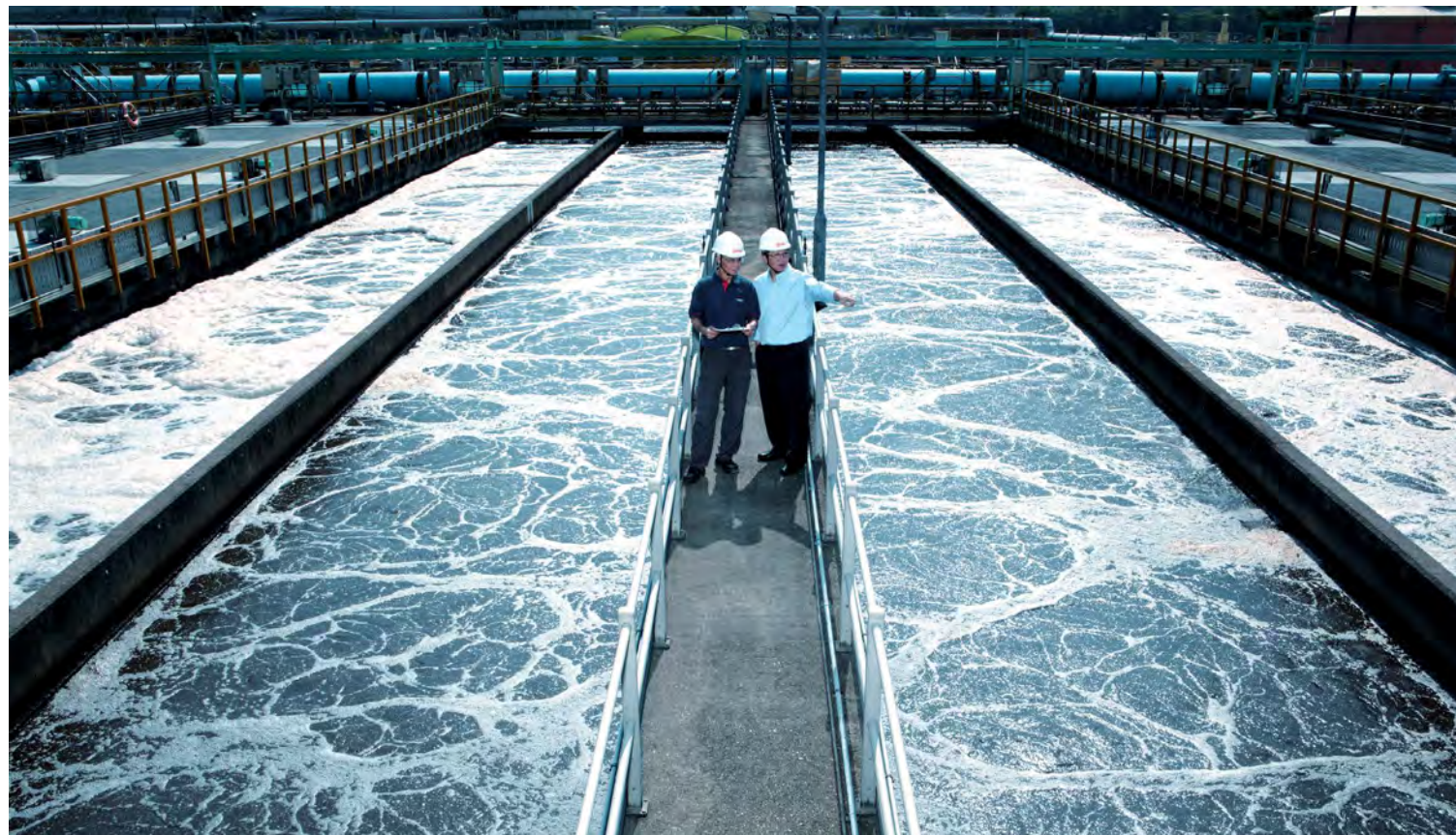
Tai Po Sewage Treatment Works 大埔污水處理廠
