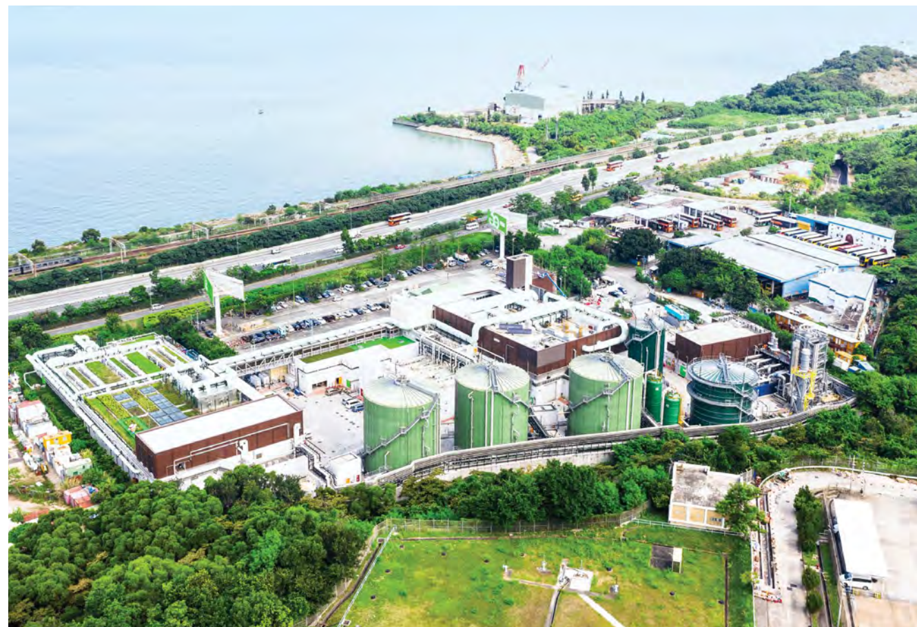
Siu Ho Wan Organic Resources Recovery Centre I (O-PARK1) 小蠔灣有機資源回收中心第一期
